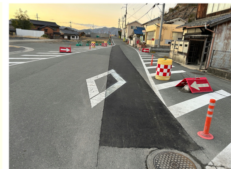
一般質問により舗装整備され段差が解消された赤穂大橋線
