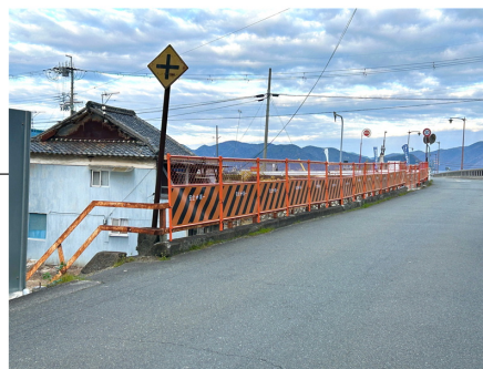
赤穂大橋線にかかる家屋解体により、落差が生じたため、転落事故防止対策を要望し、転落防止柵が設置されました。
