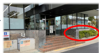
○ スロープ設置場所
